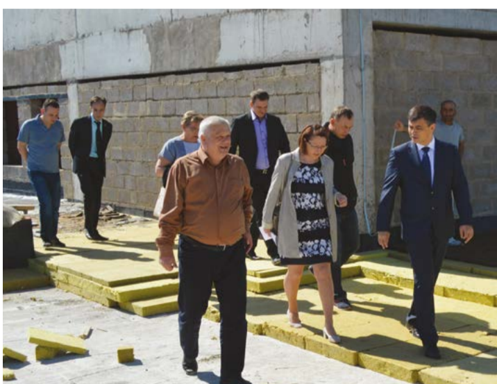
Рисунок 2. Проверка хода строительства перинатального центра в Республике Карелия (Петрозаводск), 2017 год
